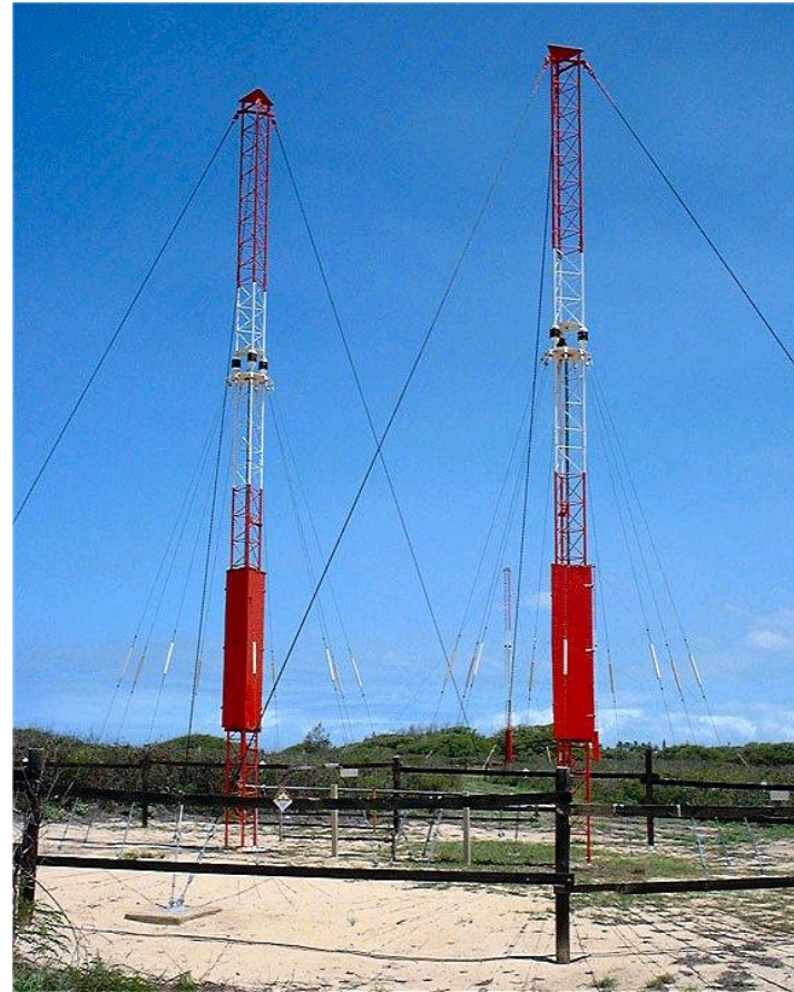
15 Mhz Antenna Array
